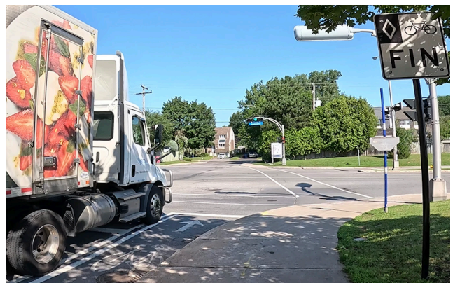
Figure 7: Fin abrupte de la voie cyclable sur l'avenue Fairview
